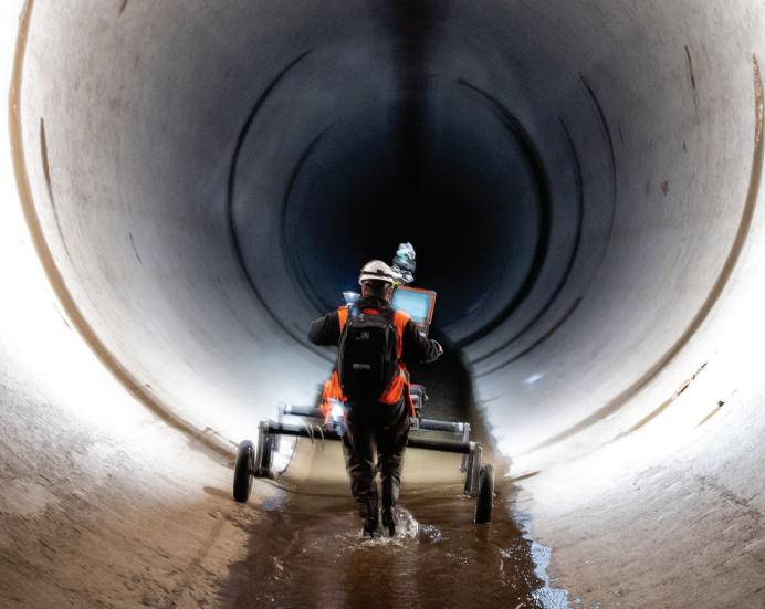
Los trabajadores usan LiDAR 3D para sondear el túnel Carley V. Porter de 20 pies de ancho y 25,000 pies de largo, que es una parte fundamental del Proyecto Estatal de Agua en el condado de Kern.
