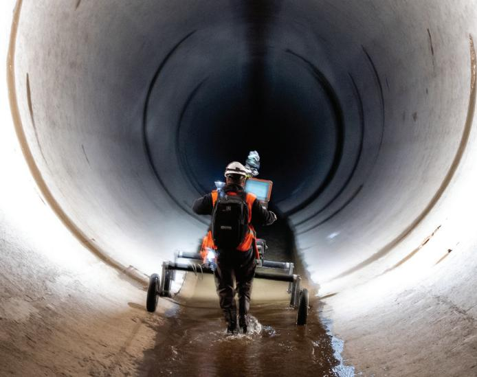
工人使用3D激光雷达 (Light Detection And Ranging, LiDAR) 技术勘测Carley V. Porter隧道, 该隧道宽20英尺、长25,000英尺, 是Kern县州水利工程的关键组成部分。
